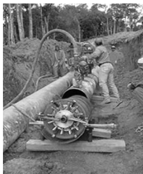
Figura 1. PIG Sendo Introduzido em um Gasoduto.
